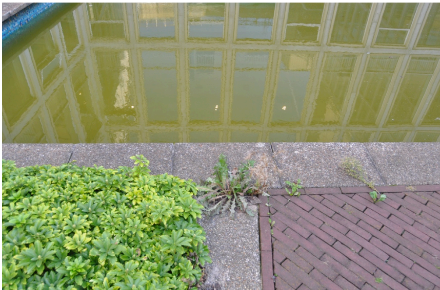
Afb. 13 Bestrating, gelegd in diagonaalverband, zoals op Plein 1945 aan de voorzijde van het Raadhuis van Velsen. Links: Pachysandra .
