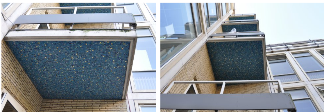
Afb. 27 Onderzijde balkons zijn van soortgelijk blauw mozaïek, als de wanden en de bodem van de Vijver.
