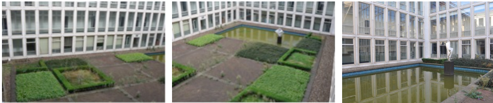
Afb. 3 De Binnenhof tijdens de renovatie van het Raadhuis d.d. 10 september 2013. Links: noordwesthoek.
