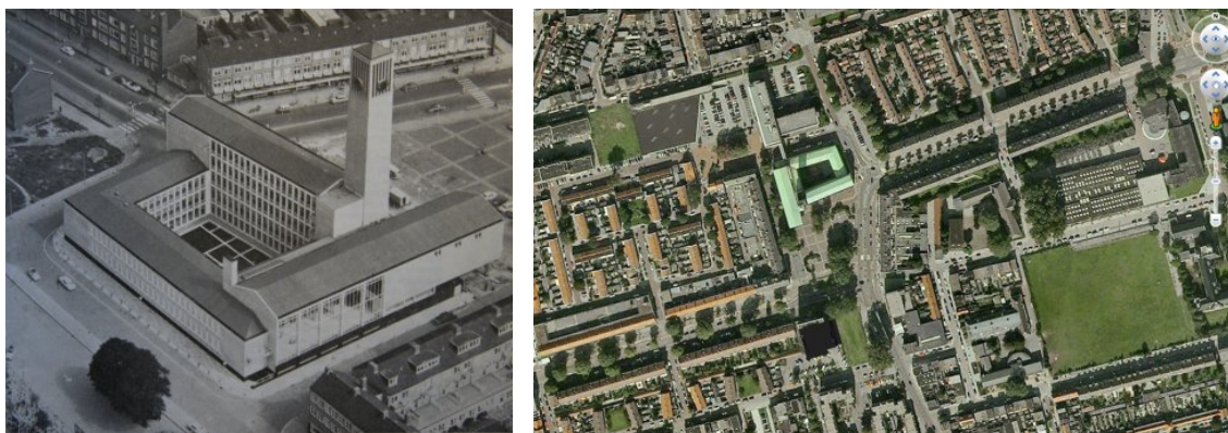
Afb. 30 Luchtfoto 1965, en daarnaast Google Earthfoto van het Raadhuis, met het zuidelijke deel in lijn met de De Noostraat. Het koperen dak (= de groene zee, op het gebouw = de blonde duinen) is goed zichtbaar. Zie Bijlage 2.
